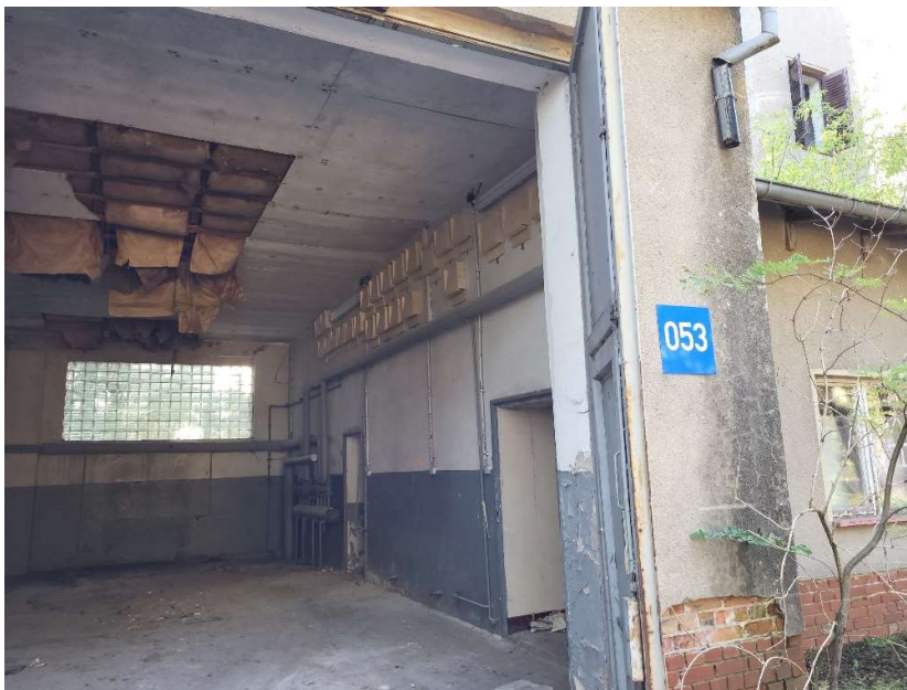
Abbildung 2: Blick auf die bereits installierten Nistkästen im Gebäude.
